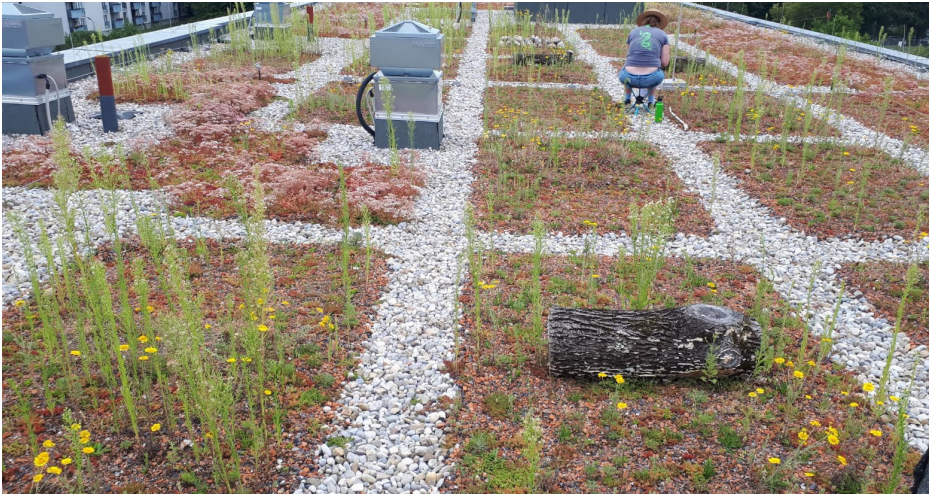
Anlage einer Dachbegrünung als Experiment zur Erhöhung des Wertes für Insekten (Foto: TP 12)
