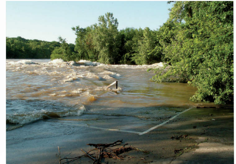
Coralville-Damm & Reservoir: Wasser fließt nach Überflutung in Iowa über den Überlauf
