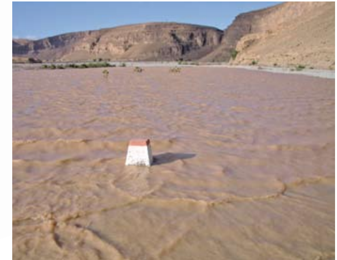
Tata nel sud del Marocco: strada allagata
