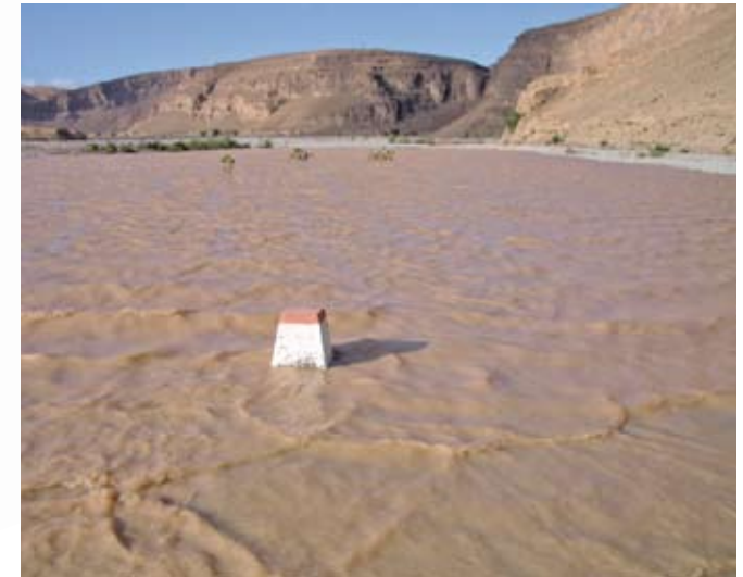
Sud du Maroc : Inondation d'une route proche de la ville de Tata
